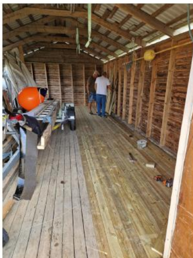
Ombyggnad av golvet i Segeltorken
